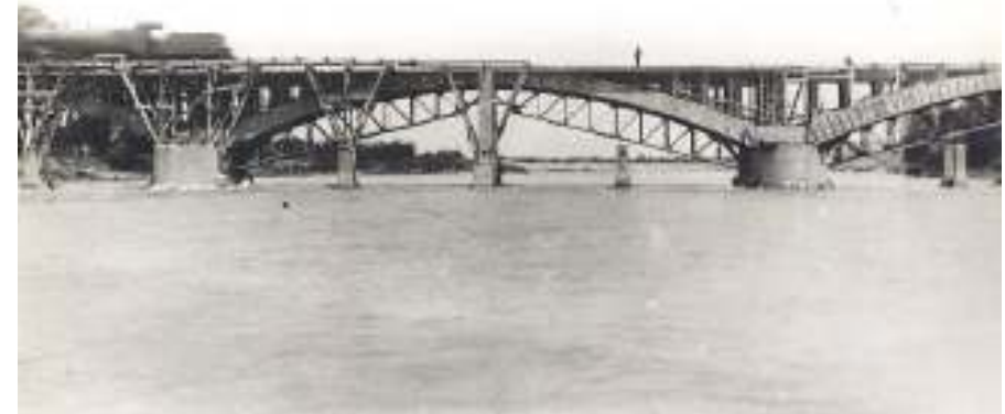
PUENTE SOBRE EL R
