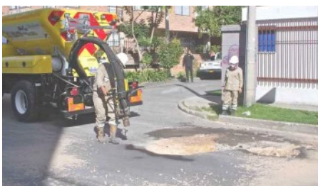
Revelan irregularidades en adjudicación de contratos para reparcho de malla vial En "Bogotá"
