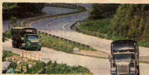
De acuerdo con la CCI, consultas previas y compra de predios han hecho complejo el avance de la vía a Buenaventura.
