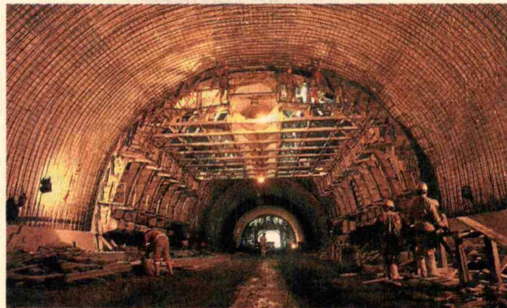
La excavación del túnel principal debió culminar esta semana, así lo prometió el contratista.
