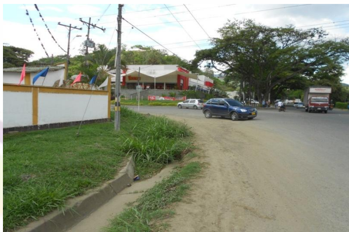
K0+000 CRUCE VIA ANTIGUA CALI-YUMBO (Inicio)
