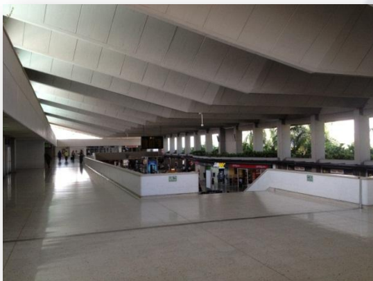
CUBIERTA EDIFICIO ACTUAL
