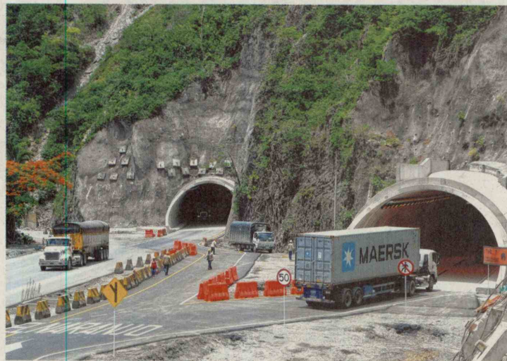
Estos son dos de los cuatro túneles de la doble calzada a Buenaventura que fueron dados al servicio recientemente. Los mismos están ubicados en el trayecto entre Loboguerrero y Cisneros.
