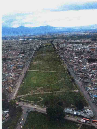
Proyectos como la construcción de la Avenida Longitudinal de Occidente (ALO) podrían afectarse por la suspensión del POT.
