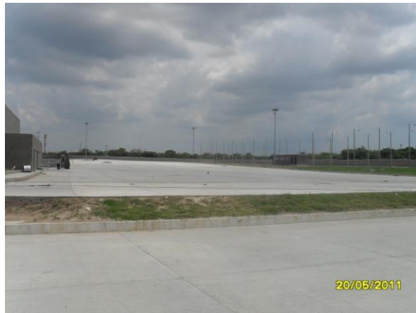
Zona de Lavado y Patio de Maniobras
