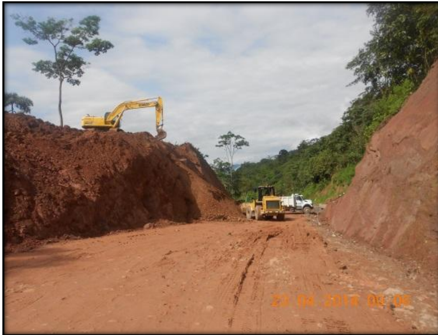
Foto N° 7. EXPLANACIÓN Y TERRACEO EN K6+140. FRENTE GUADUALES.
