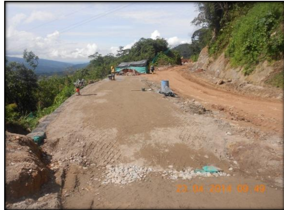
Foto N° 8: K6+460 AL K6+480 MARGEN DERECHA. CONSTRUCCIÓN DE MURO SME. FRENTE GUADUALES.
