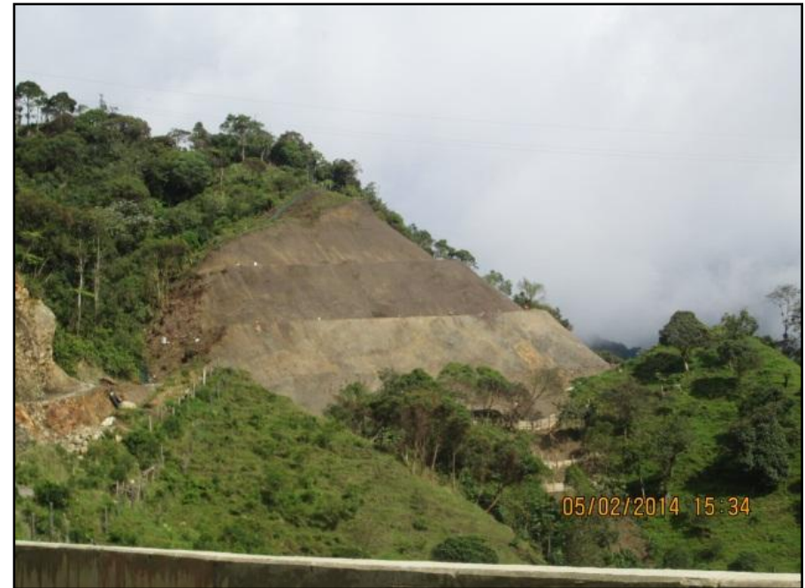
Foto N° 8. ASPECTO ACTUAL EXPLANACIÓN TERRAZAS K4+030 - K4+130 TALUD IZQUIERDO
