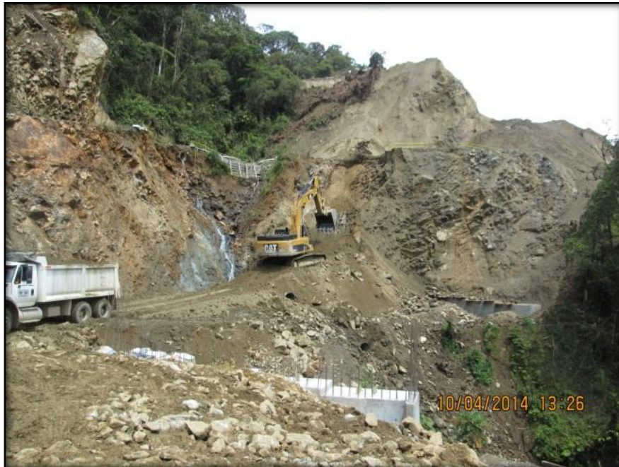
Foto N° 5. EXPLANACIÓN SECTOR K4+050 - K4+130 M.I. ALEDAÑO A PUENTE 2
