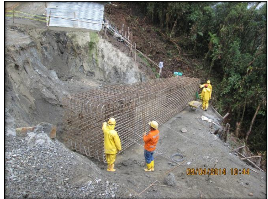
Foto N°6. AMARRE ACEROS SILLA ESTRIBO No 2 (K5+019) PUENTE 4
