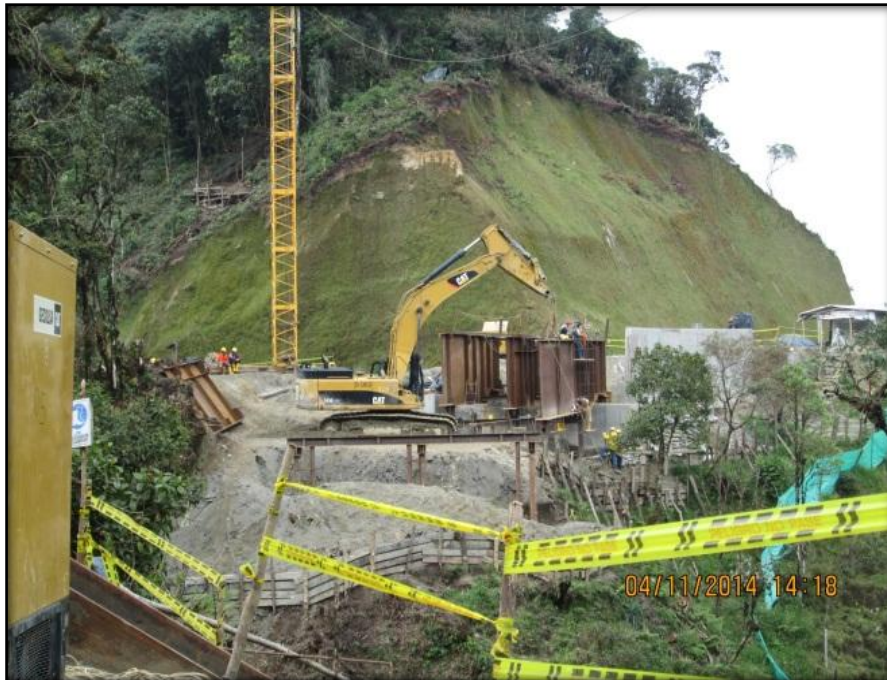
Foto No 3. MONTAJE VIGA METÁLICA TR10 SOBRE PLATINA No 1 APOYO No 2 (K5+828) PUENTE 6
