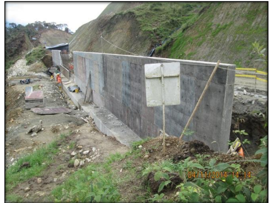
Foto No 2. MURO DE CONTENCIÓN C.P. K5+225 - K5+268
