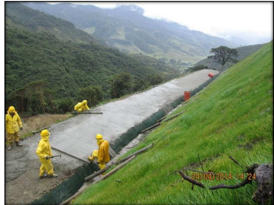
Foto No 4. REVESTIMIENTO EN CONCRETO BERMA TRAMO K4+880 - K4+960
