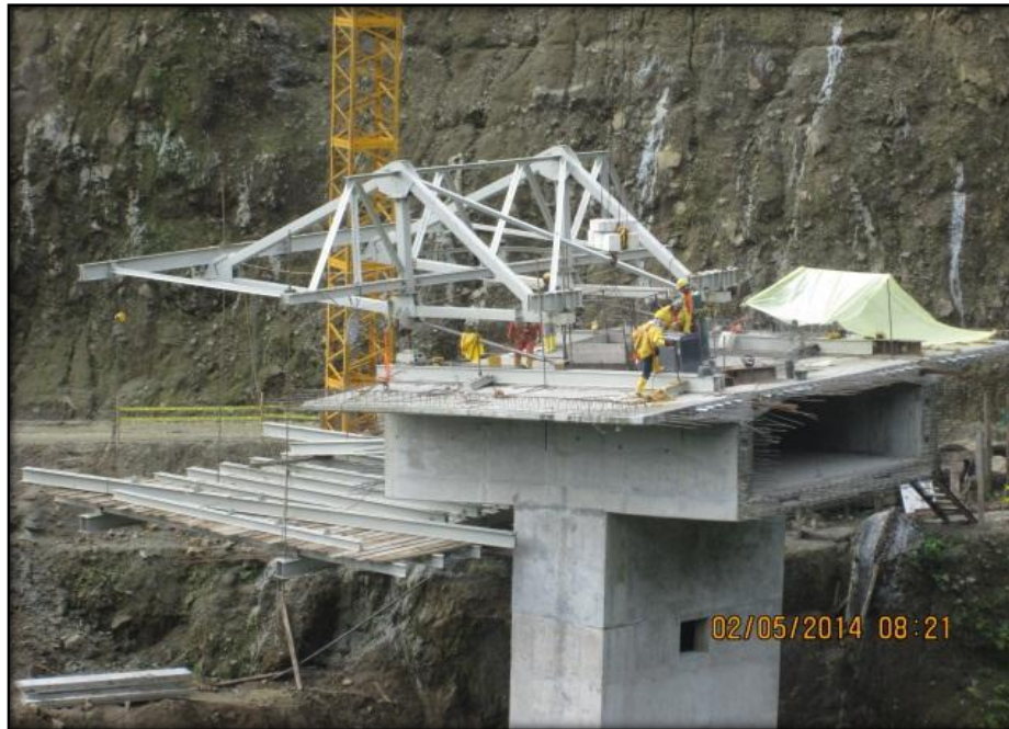
Foto N° 7. MONTAJE ESTRUCTURA METÁLICA DE ENCOFRE DOVLEAS SOBRE APOYO No 3 (K6+643) PUENTE MINCHOY
