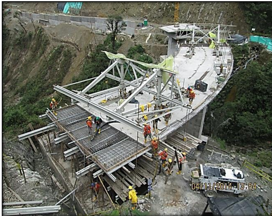
Foto No 1. PANORÁMICA ACTUAL PUENTE MINCHOY 12 DOVELAS FUNDIDAS DESDE APOYO No 2 (K6+643)
